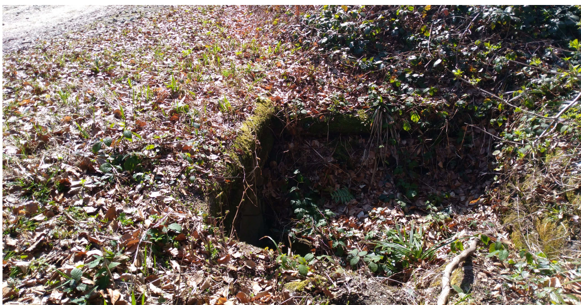
Fot. 2 Studnia z kaszycy drewnianej na wlocie do przepustu w km roboczym 0+184
